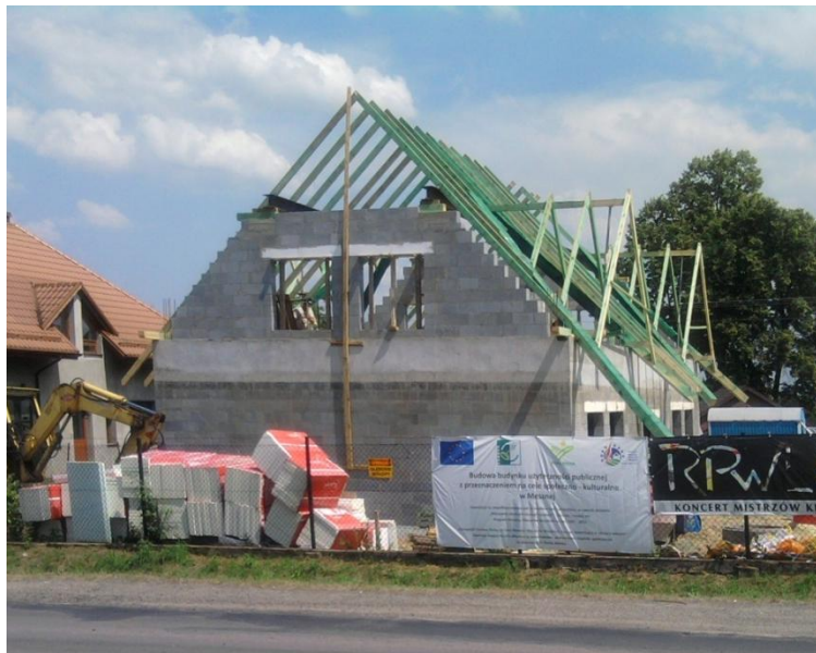
Budowa domu kultury w Mesznej ze środków na Odnowę i rozwój wsi
